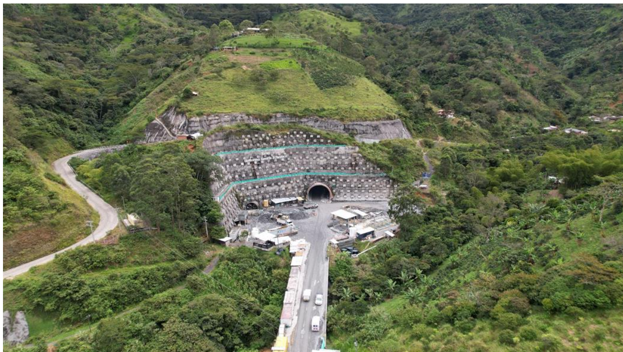
Portal Salida Túnel Principal Guillermo Gaviria Echeverri (GGE).
