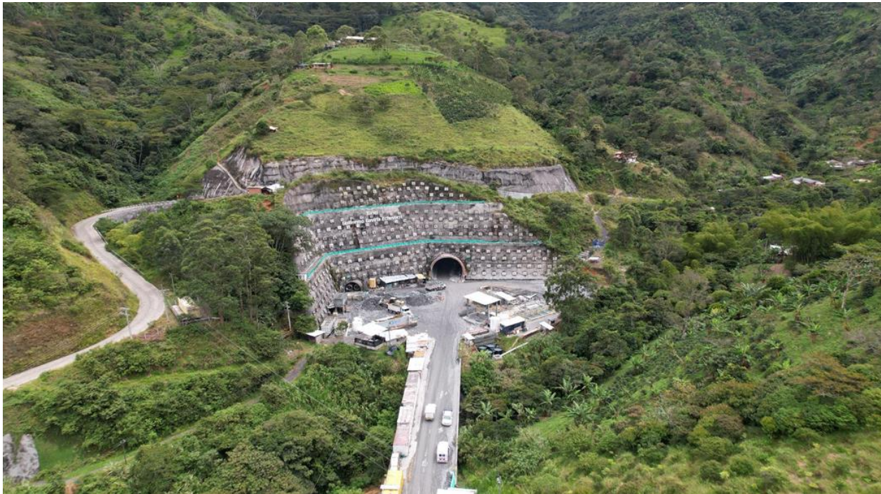
Portal Salida Túnel Principal Guillermo Gaviria Echeverri (GGE).
